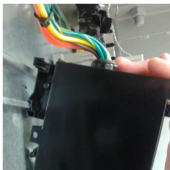
4. Rasten Sie das Trennmodul auf der DIN-Schiene ein. Alternativ kann das Trennmodul mit drei M8 Flachkopfschrauben oder einem anderen kompatiblen Befestigungselement an jeder beliebigen Oberfläche befestigt werden. Bei schwingungsintensiven Umgebungen wird die Befestigung mit Schrauben empfohlen.
