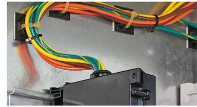
8. Verlegen Sie die Sensorleitungen und das AVT-Systemkabel und vermeiden Sie dabei scharfe Kanten, Klemmstellen und mechanische Beschädigungen.
