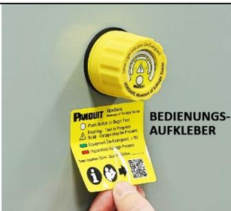
9. Bringen Sie den Bedienungsaufkleber direkt unter oder neben dem Anzeigemodul auf der Außenseite des Gehäuses an (siehe Hinweis 1). Beschriften Sie den Aufkleber, um anzugeben, wo der AVT in der Schaltung installiert ist.
