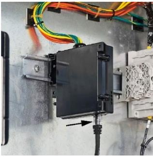
6. Stecken Sie das andere Ende des AVT-Systemkabels in den Anschluss an der Unterseite des Trennmoduls.
