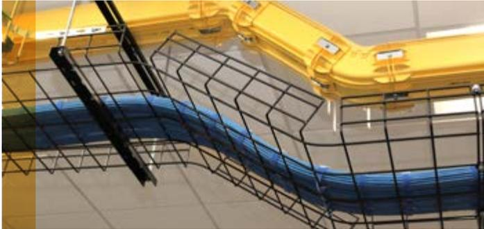
Los cambios de nivel vertical se forman fácilmente cortando secciones de la pared lateral a cada lado de la bandeja y doblando el enrutamiento al ángulo deseado.
