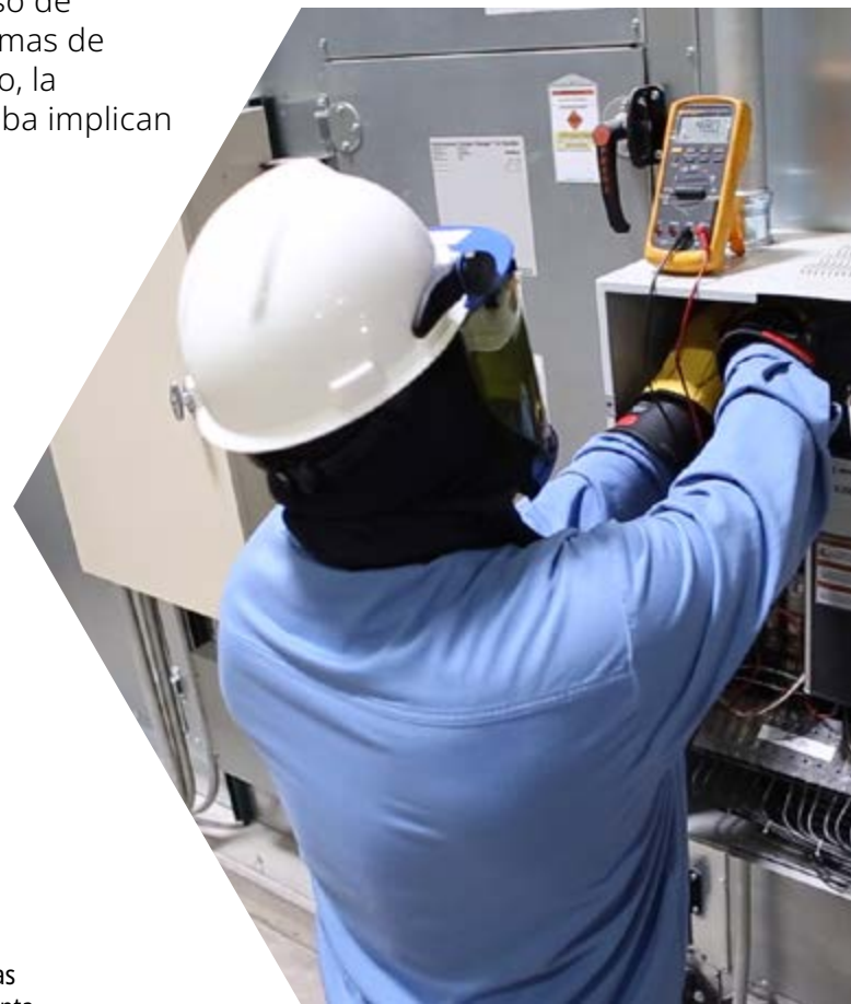
Figura 1: Prueba de ausencia de tensión utilizando un instrumento de prueba de voltaje portátil.
