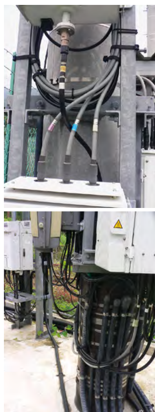
通信工事 (携帯電話用給電線の結束)
