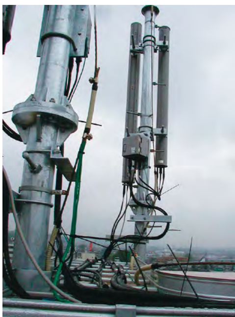
通信工事 (携帯電話用給電線の結束)
